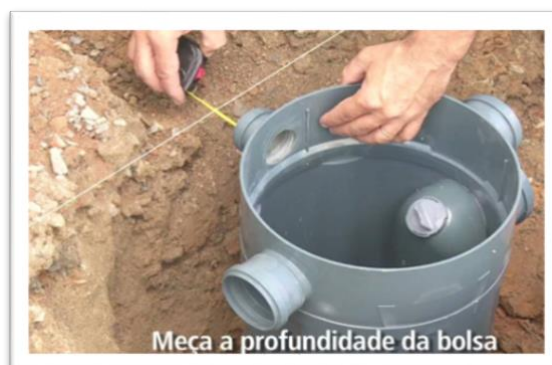
Figura 16 – Detalhe da instalação de uma Caixa de Gordura
