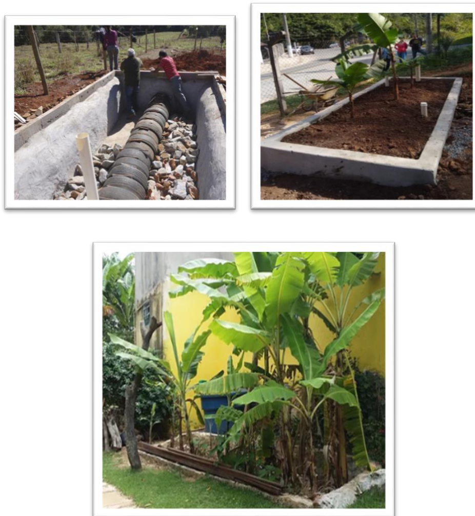
Figura 14 – Detalhe Construtivo – TEvap
